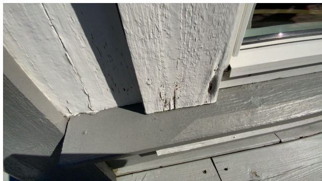
Litt råteskader.
