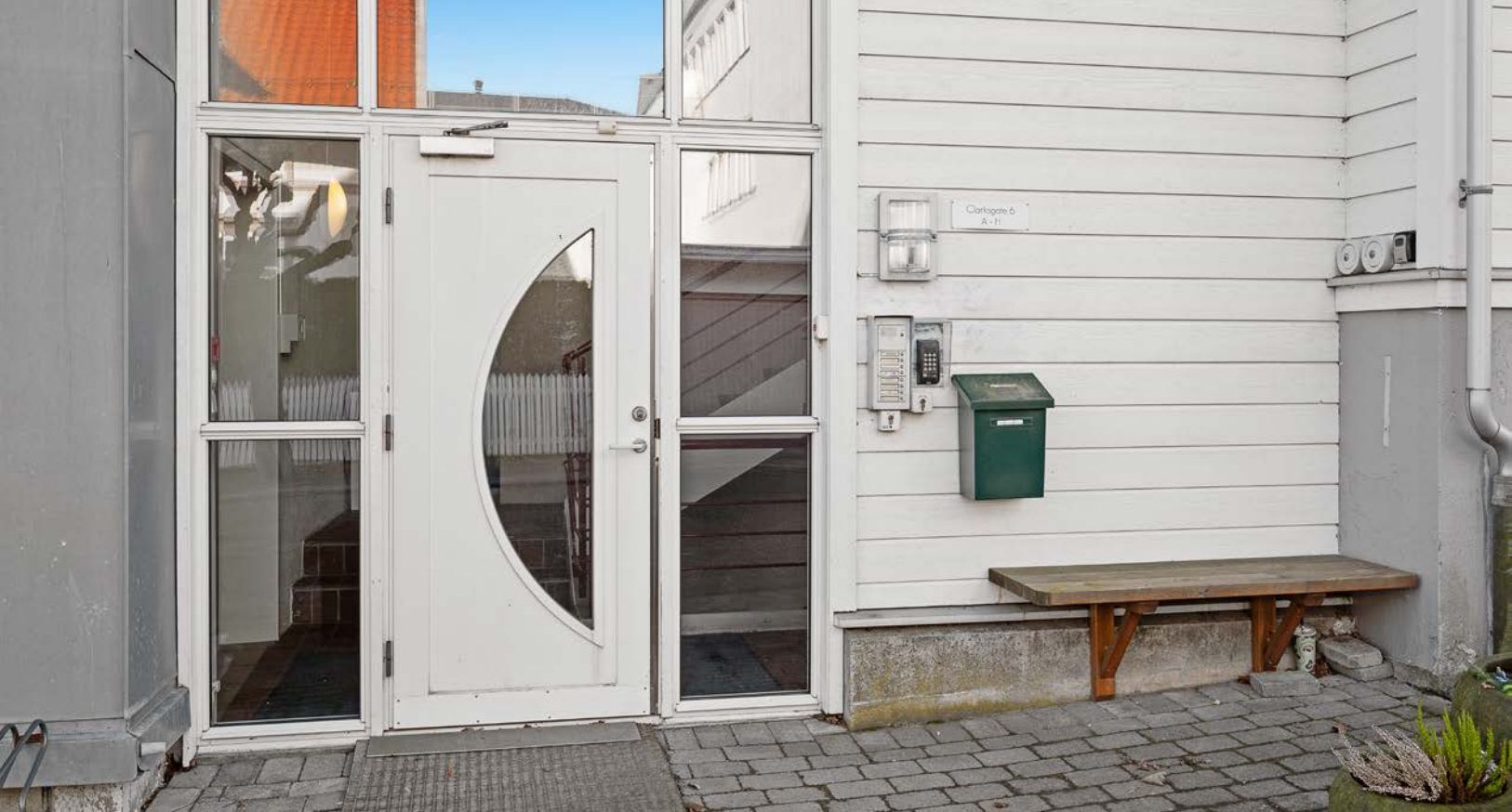
Felles inngangsparti med dørcalling - Trappefri adgang med heis opp til leiligheten, både fra gateplan og garasjekjeller
