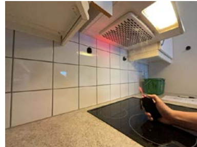
Test av ventilator med røyk
