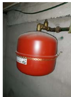
Ekspansjonstank tilknyttet fyrkjel/bereder.
