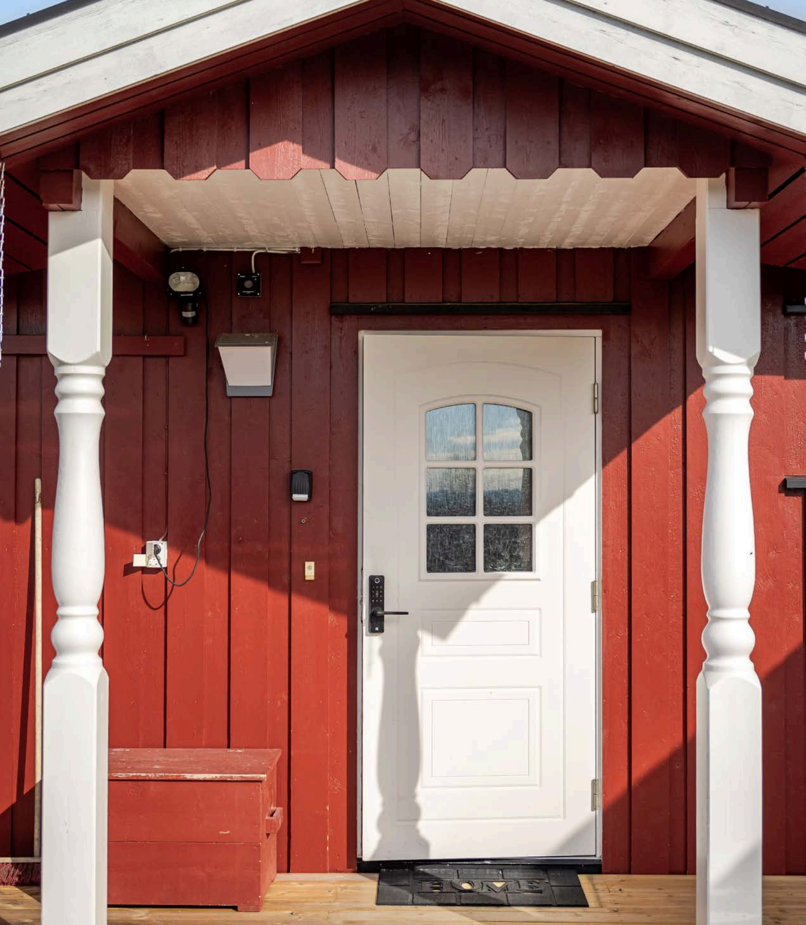
Inngangspartiet er overbygget tilknyttet den ene terrassen.
