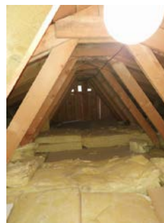
Noe varierende tykkelser av mineralull på kaldtloft.
