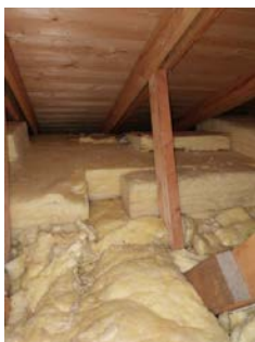
Noe varierende tykkelser av mineralull på kaldloft.
