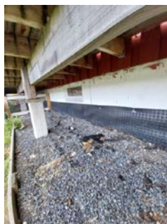
Manglende topplist ved avslutning av drencplater.
