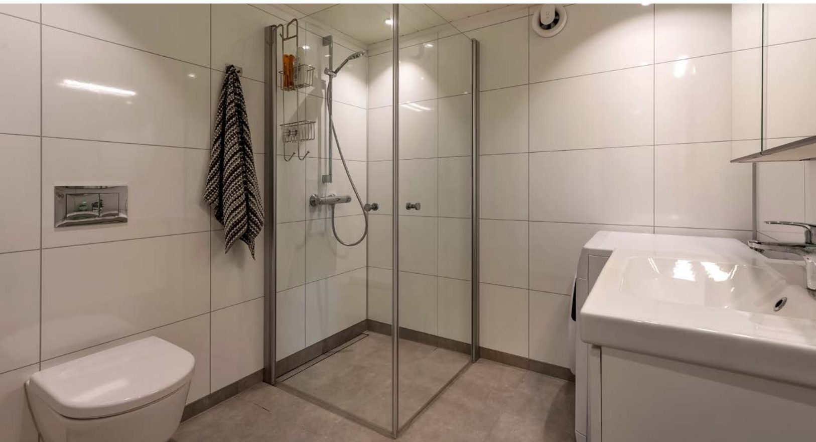
Badet i underetasjen har flislagt gulv med undervarme og ble oppgradert i 2022
