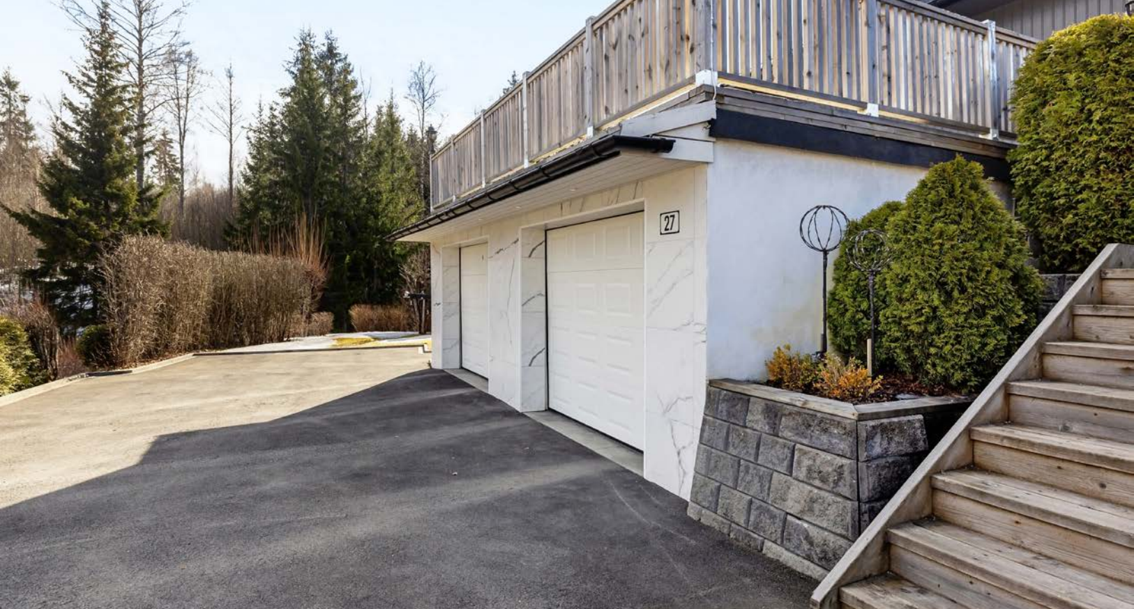
Dobbel garasje, samt asfaltert gårdsplass.
