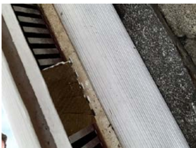
Lufting og ekstra isolert.
