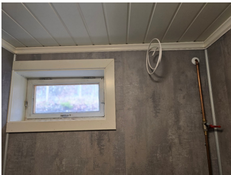
Manglende ventilasjon.
