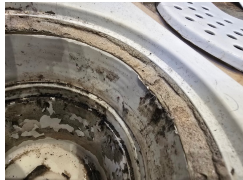
Sluk i plast uten synlig membran.
