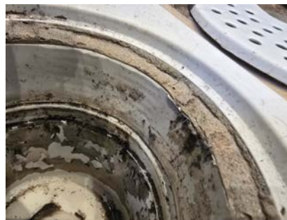
Sluk i plast uten synlig membran.
