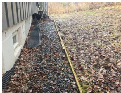
Fall mot grunnmur.
