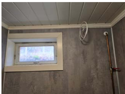
Manglende ventilasjon.
