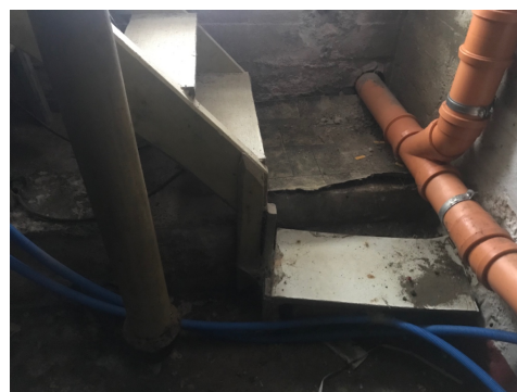
Avløpsrør til høyre plast fra tilbygg og til venstre støpejernsrør fra bad 2 etg
