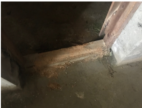
Dørkarmen råteskader.
