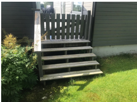
Mangler rekkverk
