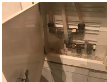
Rørskap plassert i bad i 2.etg.
