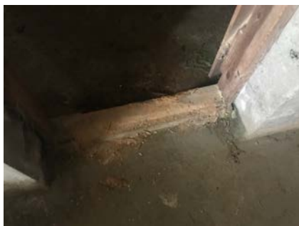
Dørkarmer råteskader.
