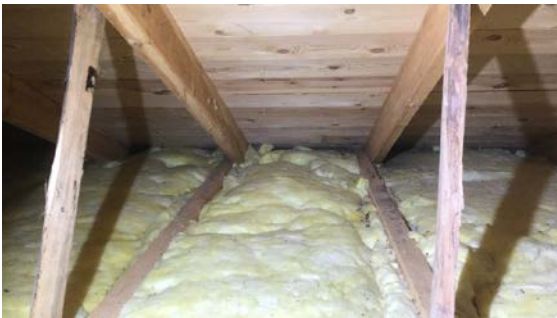
Tett i nedkant takutstikk
