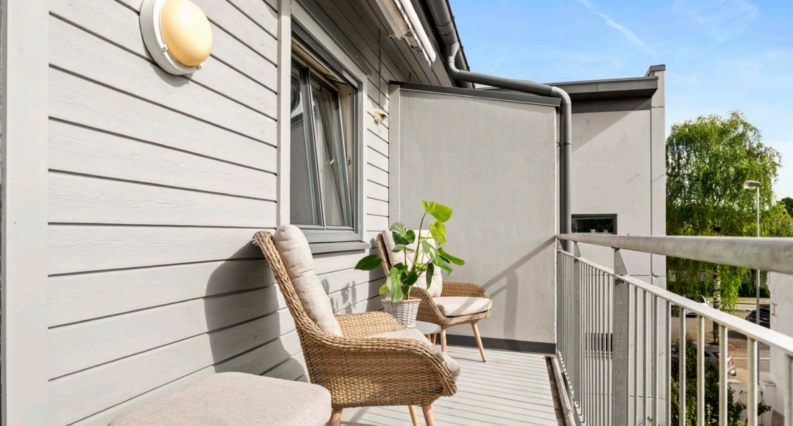
Balkongen har støpt betongdekke og god plass til sittegruppe etter eget ønske og behov. Det er også montert markise, utebelysning og stikkontakt.
