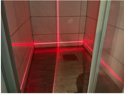
Fall på baderomsgulv er kontrollert med krysslaser.
