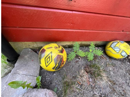
Ikke synlig vorteplast/fuktsikring. N/Ø hjørne
