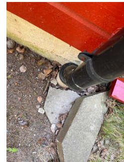
Ikke synlig vorteplast/fuktsikring. N/V hjørne
