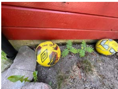
Ikke synlig vorteplast/fuktsikring. N/Ø hjørne
