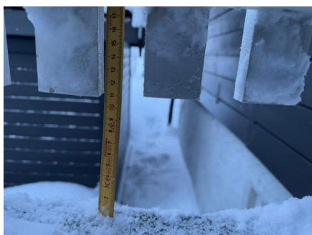
Åpning under rekkverk.
