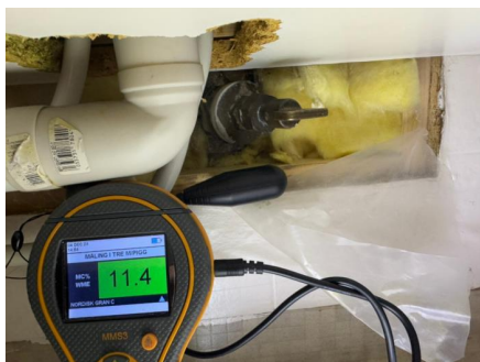
Fuktmåling under servant.
