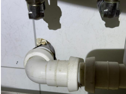
Utetthet rundt rørgjennomføring.
