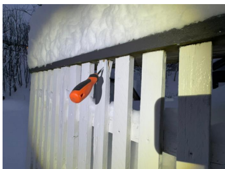
Råteskadet rekkverk.
