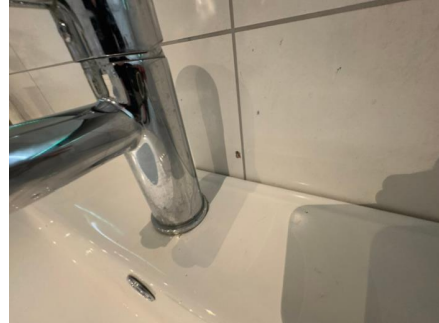
Eksempel på puktering av membranen.
