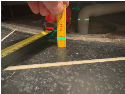
Måling ved sluken under dusjkabinettet.
