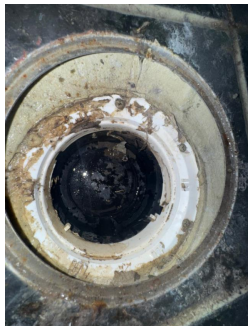
Utetthet rundt rørgjennomføring.
