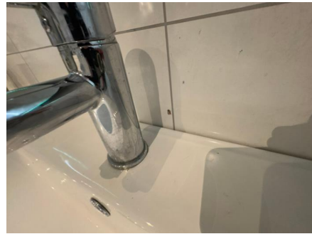
Hull etter tidligere montert utstyr.
