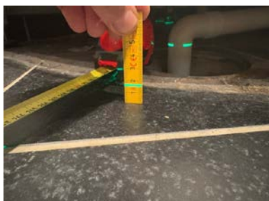
Måling ved sluken under dusjkabinettet.
