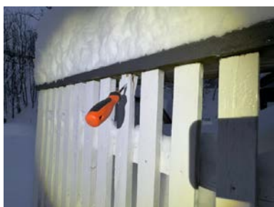
Råteskadet rekkverk.
