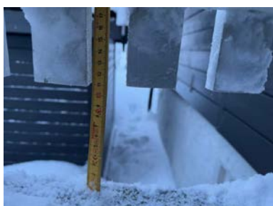
Åpning under rekkverk.
