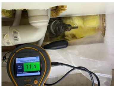
Fuktmåling under servant.
