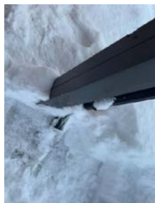
Nedløp fra takoverbygg er avsluttet over terreng med utkaster.
