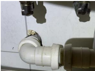
Utetthet rundt rørgjennomføring.
