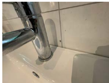
Hull etter tidligere montert utstyr.
