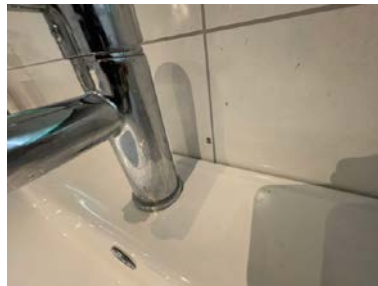
Eksempel på puktering av membranen.
