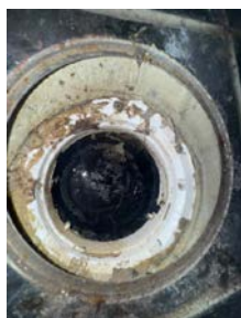
Utetthet rundt rørgjennomføring.
