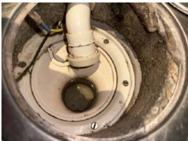
Plastsluk med klemring for membran
