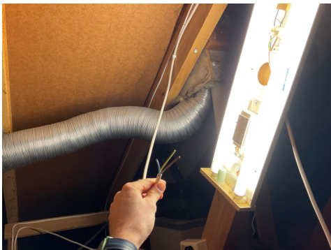
Eksempel på ledning uten endestykke.
