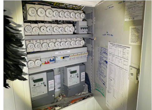
Skrusikringer er fra byggetid.
