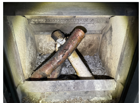
Slitasje inne i vedovn
