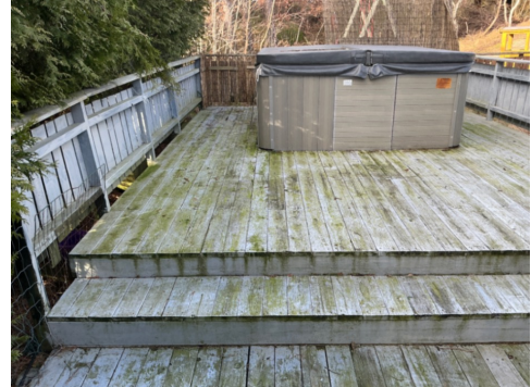
Terrassedekke har ujevn overflate
