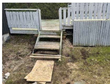
Terrassedekke har ujevn overflate
