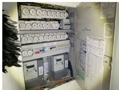
Skrusikringer er fra byggetid.
