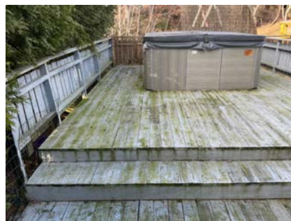
Terrassedekke har ujevn overflate
