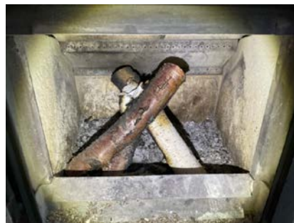
Slitasje inne i vedovn
