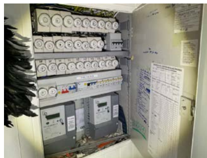
Skrusikringer er fra byggetid.
