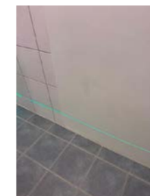
Gipsplate montert ned mot gulvet. Dette arbeidet ble utført i 2023.
