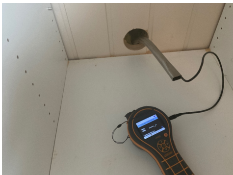
Hulltaking i kjøkkenskap
