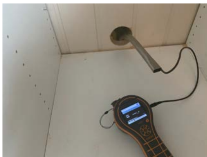
Hulltaking i kjøkkenskap
