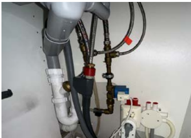
Rørøpplegg i kjøkkenbenk med Waterguard
