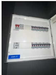
Sikringsskap med automatsikringer.
