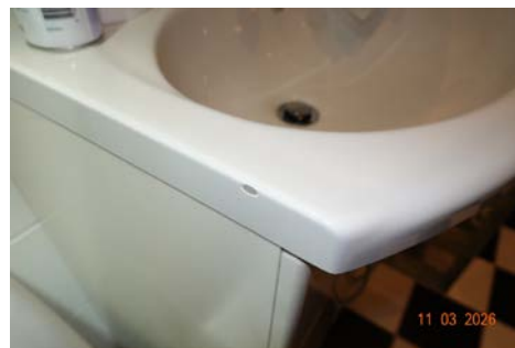
LEILIGHETEN I 3.ETASJE > BAD/VASKEROM
