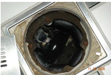
LEILIGHETEN I 3.ETASJE > BAD/VASKEROM
