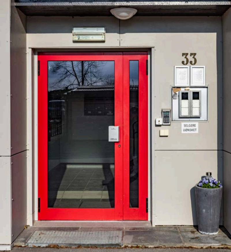
Felles inngangsparti med dørcalling.
