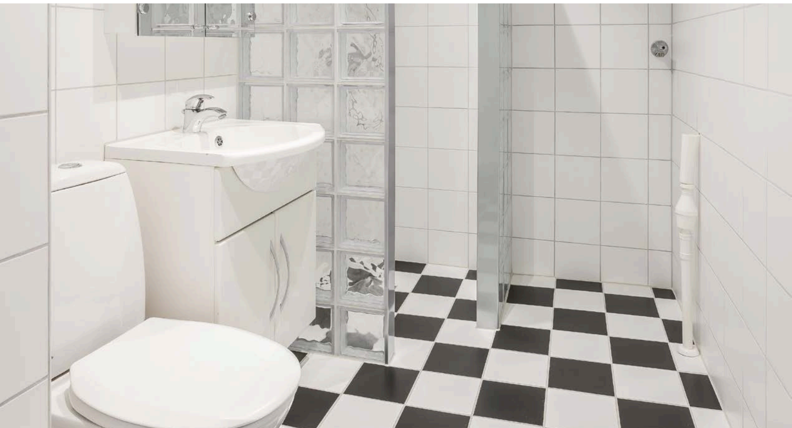
Flislagt bad med elektriske varmekabler i gulvet og downlights i himlingen.
