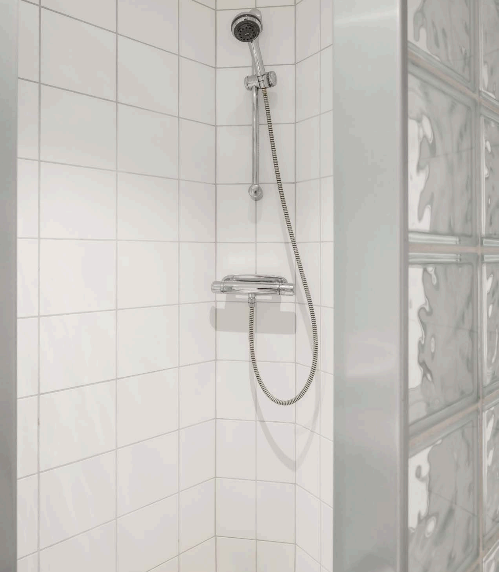
Dusjnise med glassbyggerstein og veggmontert dusjbatteri.
