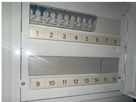
Sikringsskap med automatsikringer.
