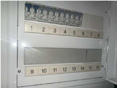
Sikringsskap med automatsikringer.
