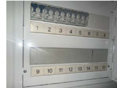
Sikringsskap med automatsikringer.
