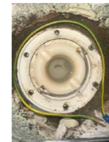
Sluk i plast, plassert i dusjnisje
