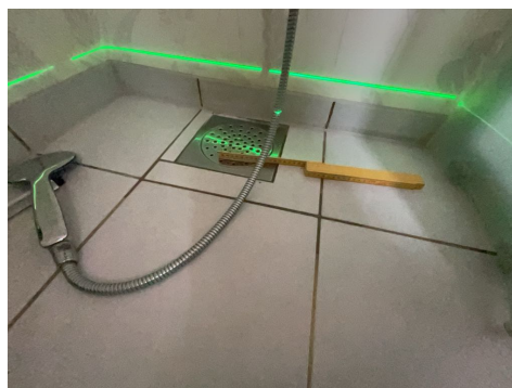
Det er ikke etablert tilstrekkelig fall på gulv mot sluk i dusjnise.
