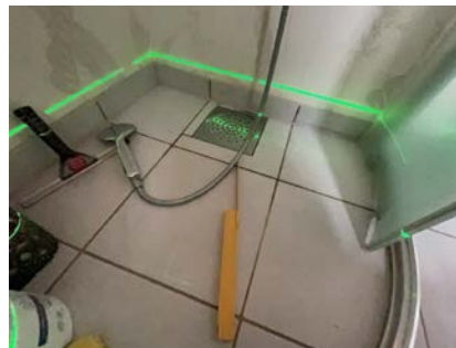
Det er ikke etablert tilstrekkelig fall på gulv mot sluk i dusjnise.
