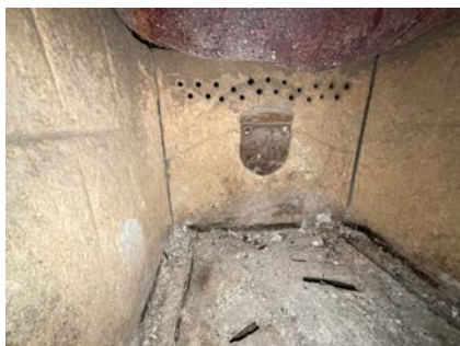
Det er påvist sprekker i ildfast stein inni vedovn.
