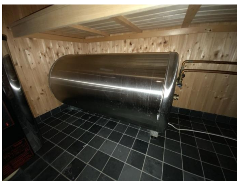
Besiktigelse av bereder.
