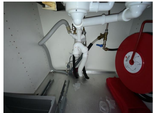
Besiktigelse av røropplegg.
