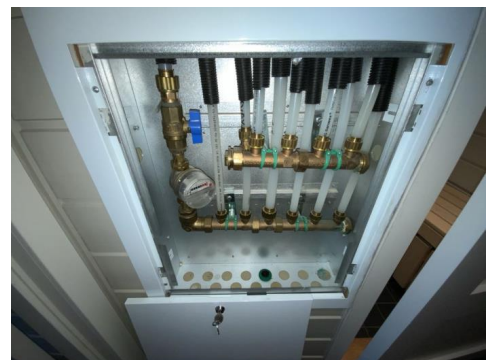
Besiktigelse av røropplegg.
