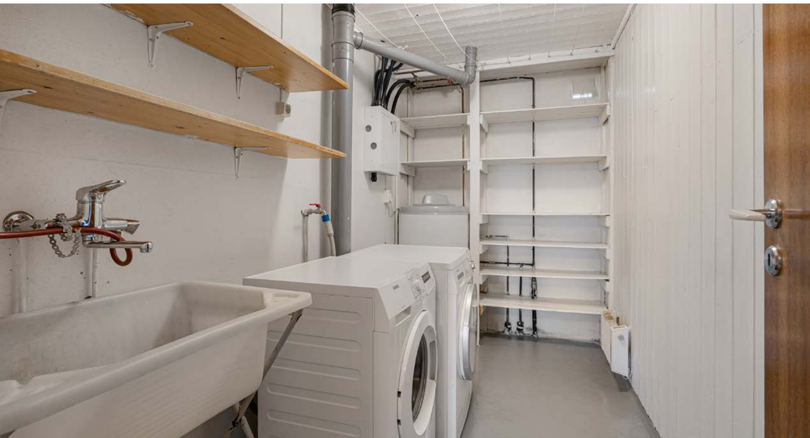
Vaskerommet ligger i underetasjen og har skyllekum, varmeovn og åpne hyller.
