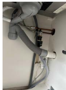
Røropplegg i kjøkkenbenk med Waterguard
