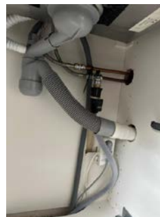
Røropplegg i kjøkkenbenk med Waterguard
