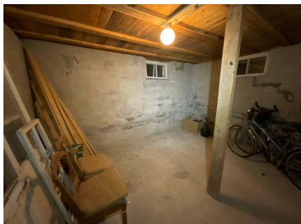
Vinduer i vegg er inn til krypkjeller.
