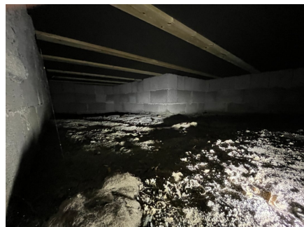
Bilde tatt fra vindu.
