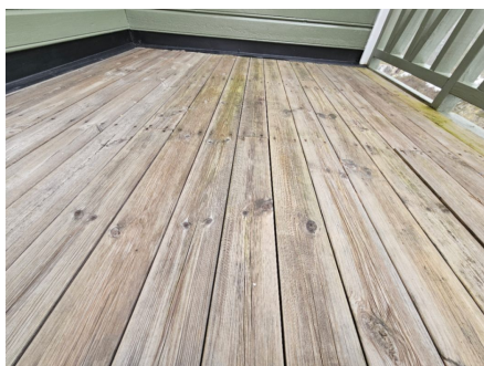
Spaltegulv på balkong.
