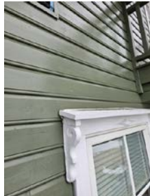
Vindu med manglende overliggende beslag
