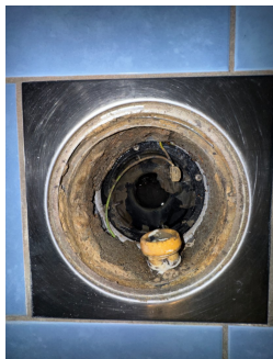
Plastsluk med klemring og synlig membran
