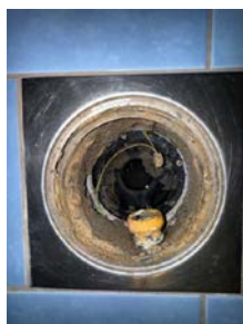
Plastsluk med klemring og synlig membran
