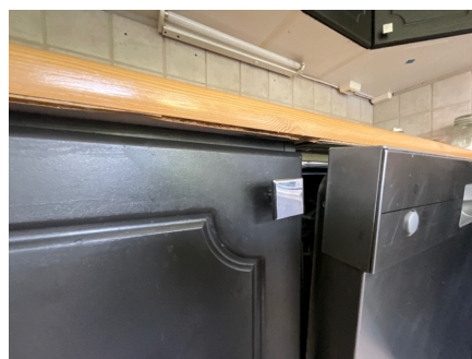
Skader på innredningen.
