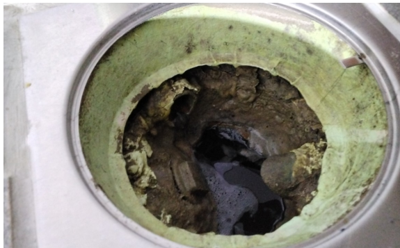
Støpejernsluk under innredning
