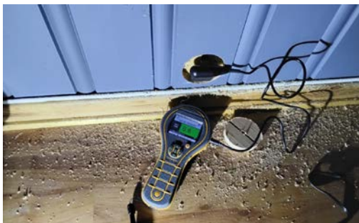
Fuktsøk i påforet vegg i kjeller
