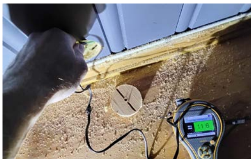
Fuktsøk i påforet vegg i kjeller
