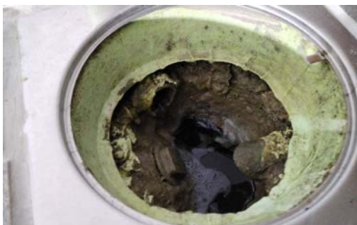
Støpejernsluk under innredning
