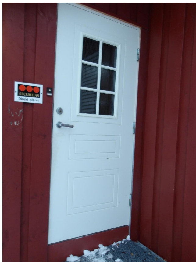
Ytterdør i 1. etasje.
