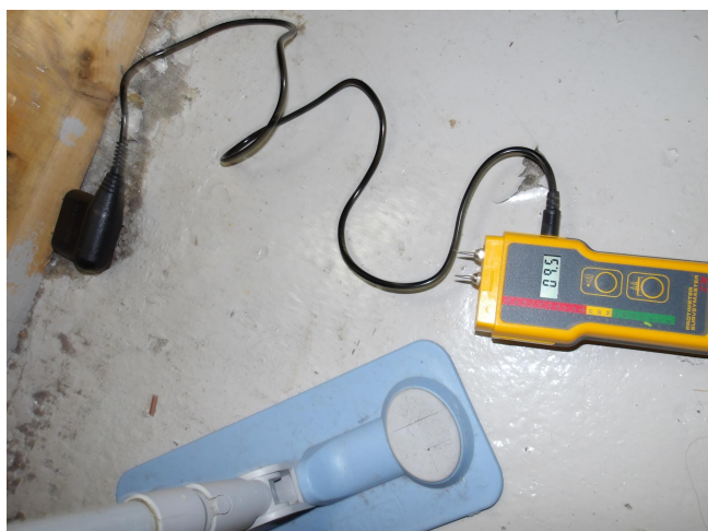
Fuktmåling bak dusjkabinett
