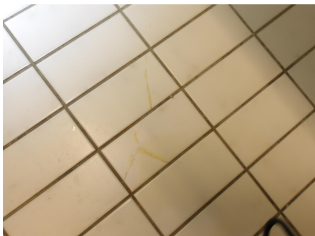
Sprikker på i fliser.
