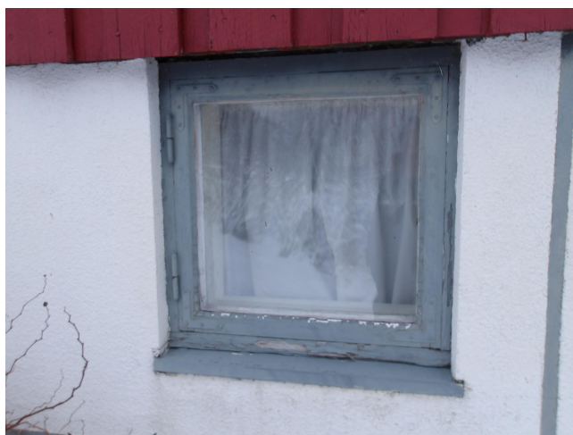
Noen koblede kjellervinduer er fra byggeår.
