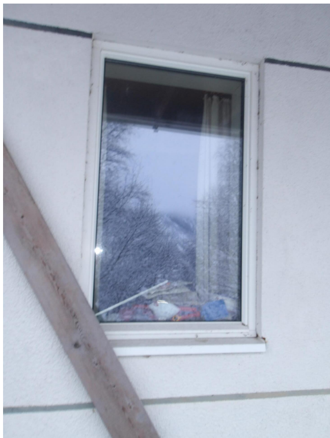
De fleste kjellervinduene er skiftet.
