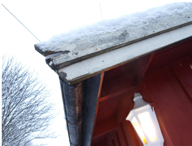
Skadet vindskibord
