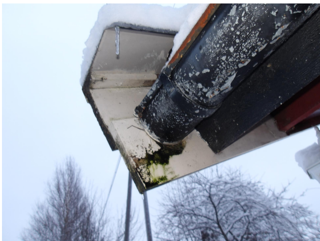
Skadet vindskibord.
