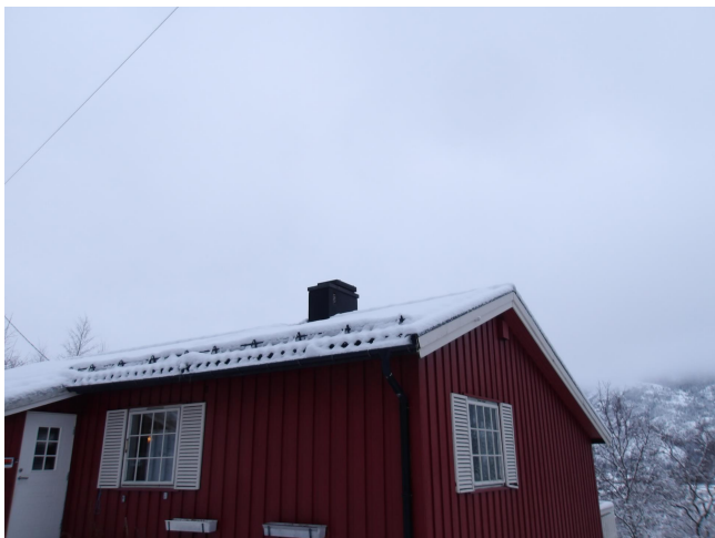
Pipebeslag og snøfangere.
