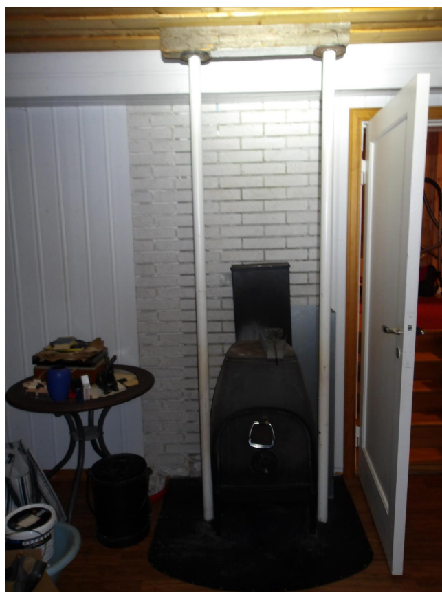
Ildsted i kjeller.
