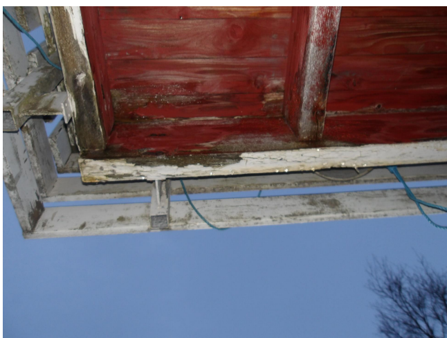
Råteskader.
