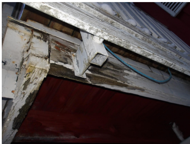
Råteskader.
