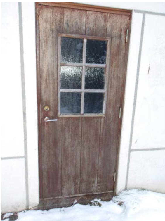
Ytterdør i sokkel.
