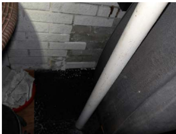
Forblendingsstein bak ildstedet i kjeller har løsnet.
