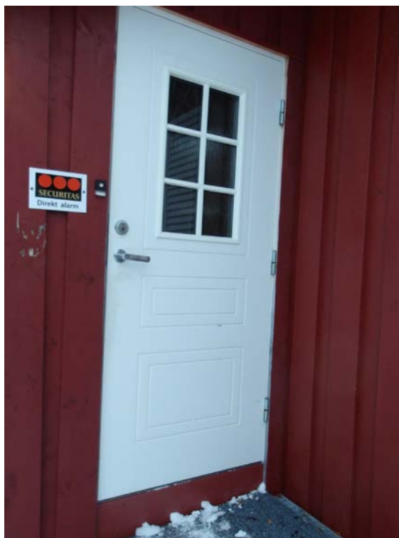
Ytterdør i 1. etasje.
