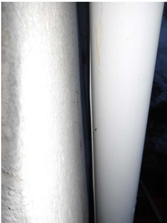
Skade i fals på nedløp.
