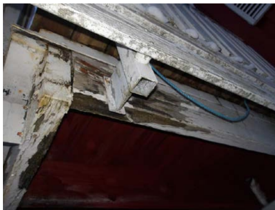
Råteskader.
