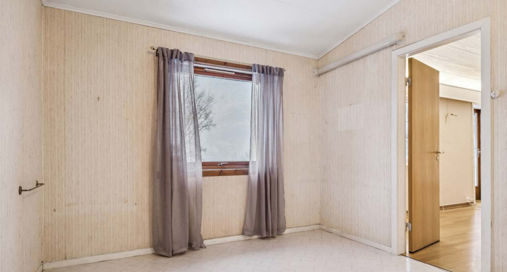
Soverommet i 1.etg. har tapet på veggene og malte himlingsplater, med god lysinnslipp fra vinduet.
