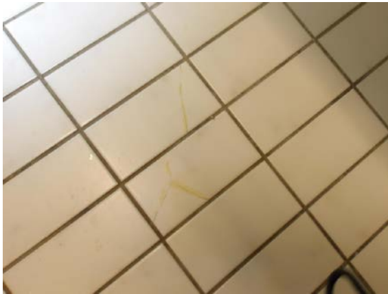
Sprikker på i fliser.
