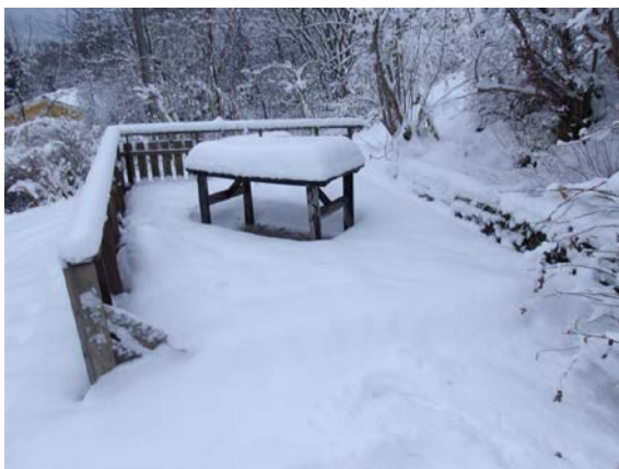
Platting på terreng.
