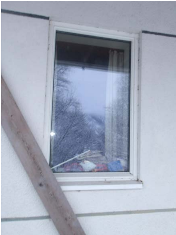
De fleste kjellervinduene er skiftet.
