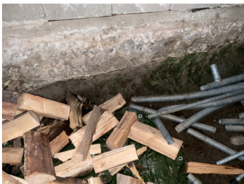
undergravd grunnmur i vedbod
