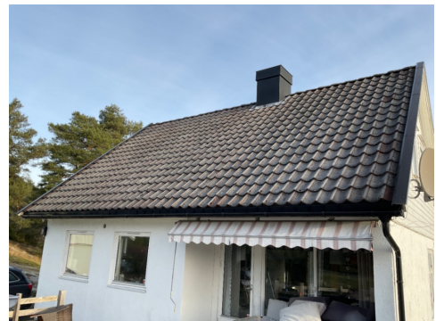
Takteking av betongtakstein
