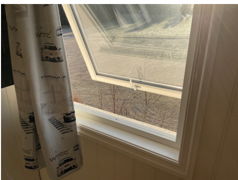
Vindu i 2. etasje
