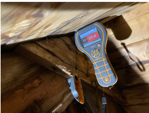
Fuktmåling på loft
