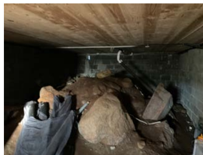
Krypkjeller under kjøkkenet
