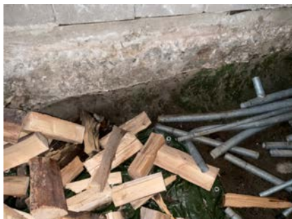
undergravd grunnmur i vedbod
