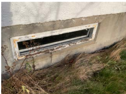
Kjellevindue på endevegg
