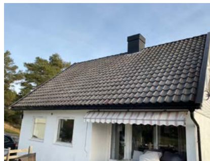
Taktekking av betongtakstein
