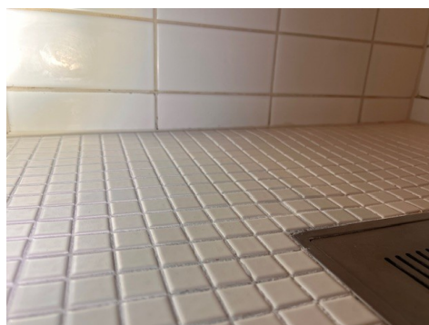
Dusjsone med bulker i gulvet.
